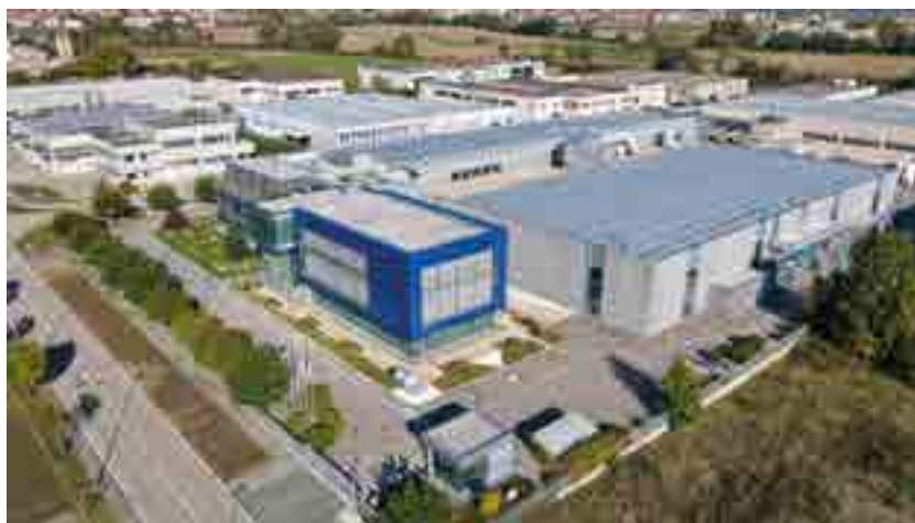
Panoramica dello stabilimento ATLA di Chieri (TO)
